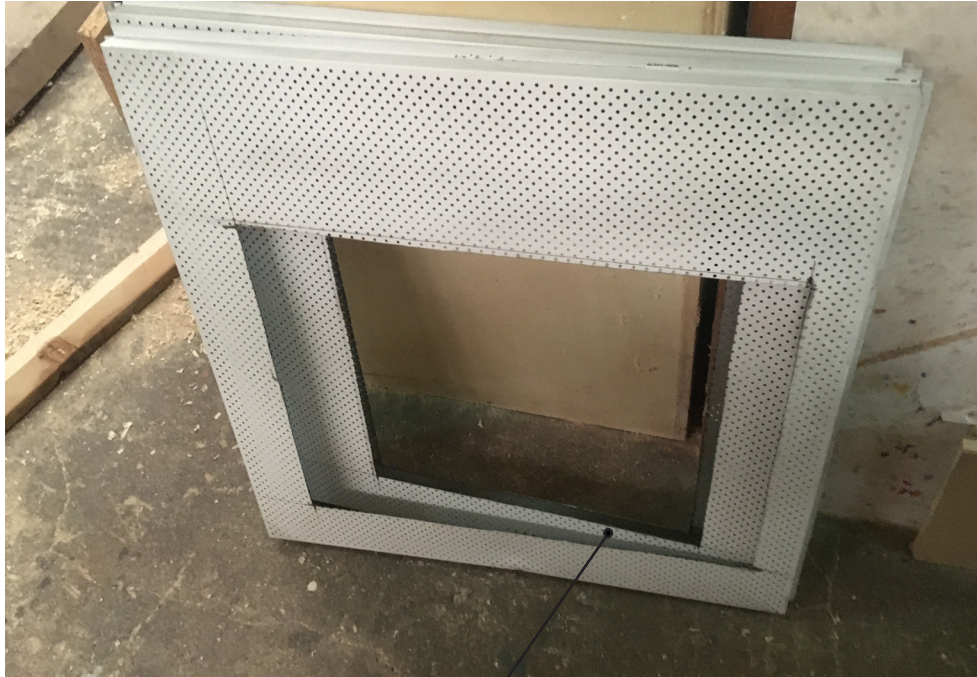
Chute de dalle de faux-plafond
