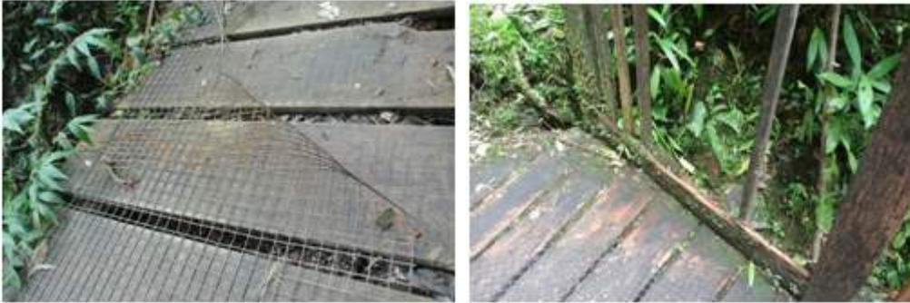
*Exemples de dégradation des sentiers (Grillage antidérapant dangereux garde-corps dégradé)*
