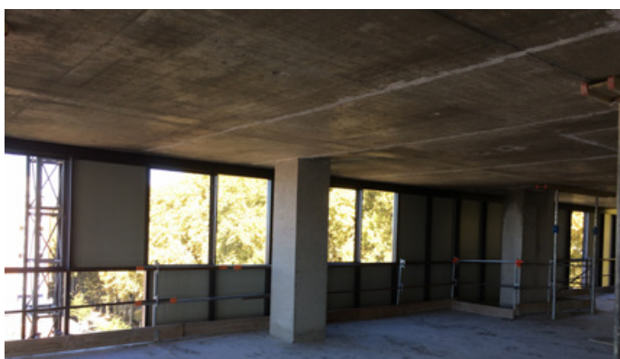
Vue de l'intérieur - chantier en cours (Octobre 2018)
