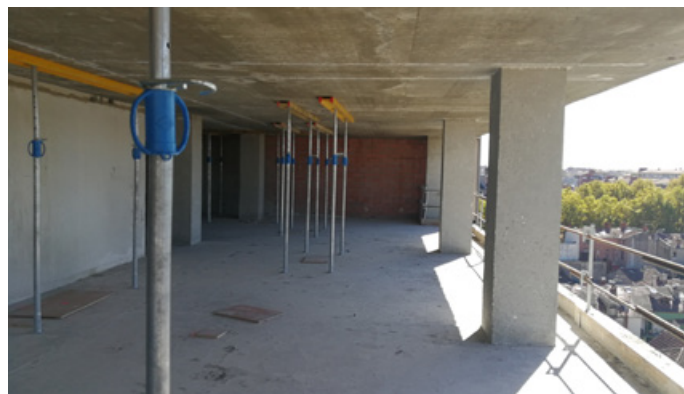
Vue de l'intérieur et des poteaux en béton (Octobre 2018)
