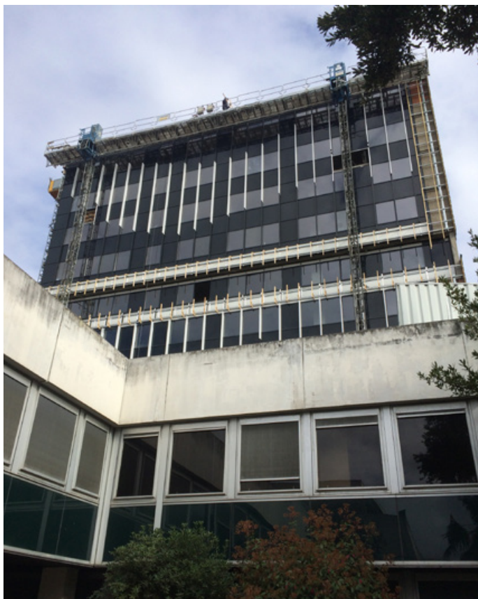
Vue de l'extérieur - chantier en cours (Mars 2019)
